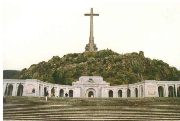
Basilica de Santa Cruz, Valle de los Caídos
