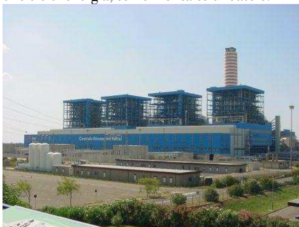
La centrale di Montalto di Castro
